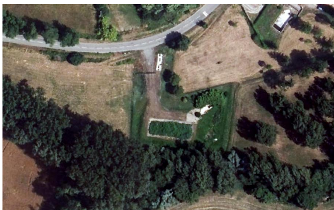
Dégrilleur – Déversoir d'orage - Ouvrage de chasse
