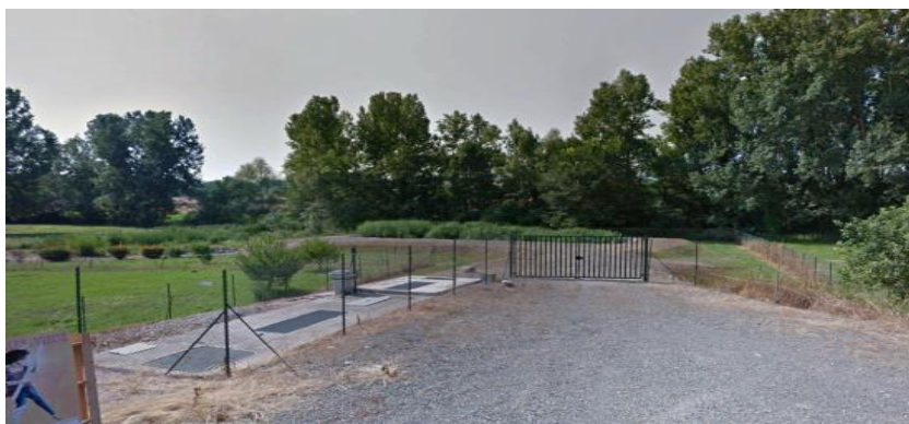
Filtres plantés de roseaux
