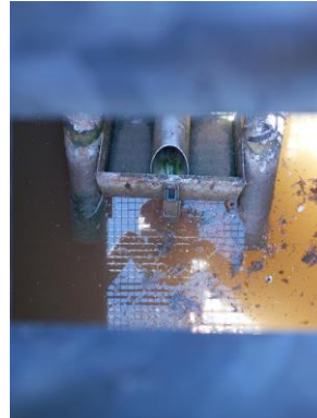
Ouvrage de bâchée
