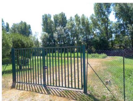
Entrée station (Portail)
