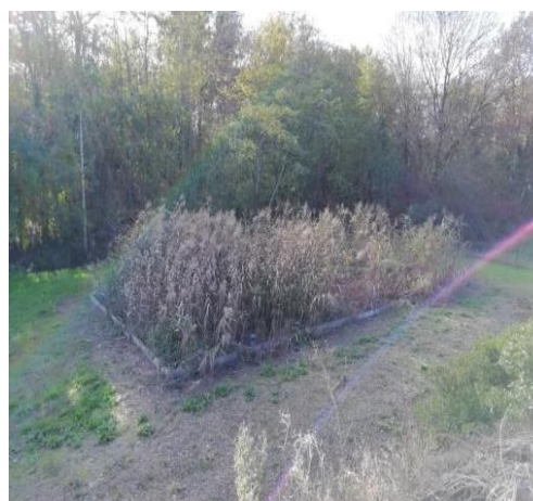
Filtres étage n°2
