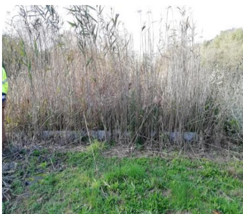
Filtres étage n°1
