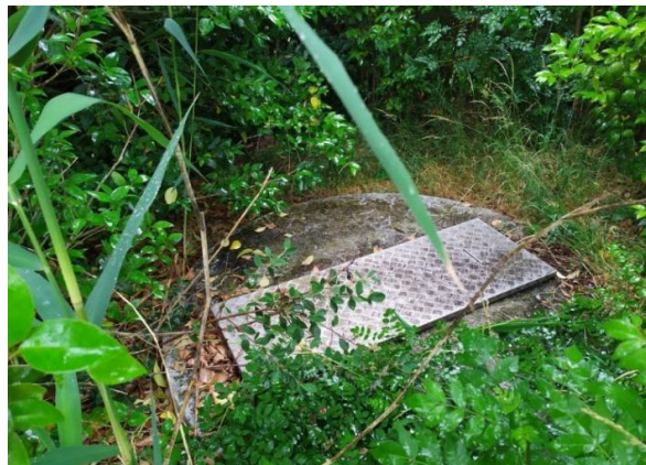
Chasse hydraulique 2nd étage
