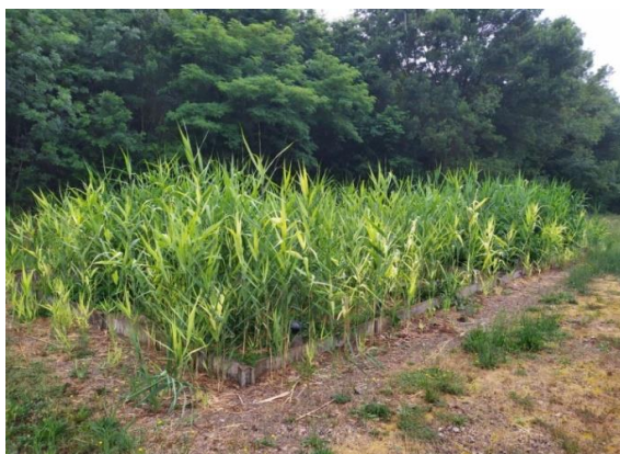
2eme étage de filtre planté de roseaux
