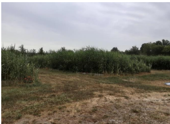
Filtres plantés de roseaux
