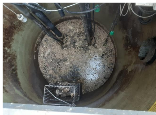
Intérieur du PR 1
