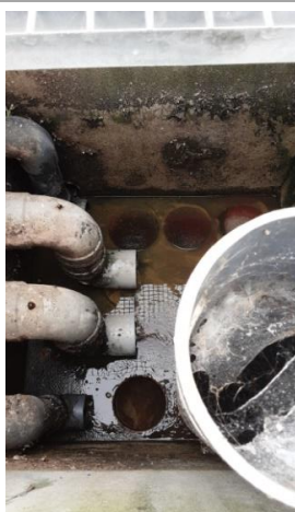
Ouvrage de répartition
