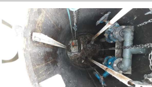
Bâche du poste de relevage (absence chambre de vannes)
