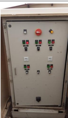
Armoire électrique (voyant défaut allumé pour la pompe de recirculation du clarificateur)
