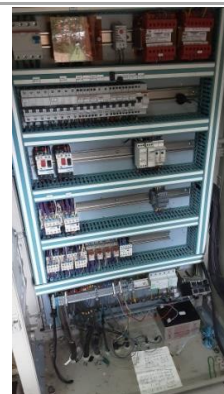
Armoire électrique - Soffrel S550
