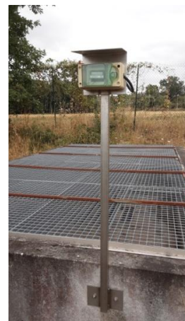
Compteur de bâchées
