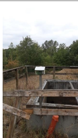
Compteur de bâchées
