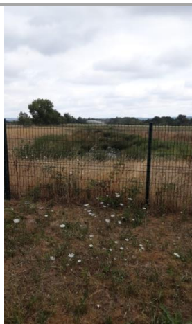
Rejet dans bassin de retention
