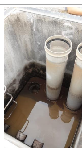
Ouvrage de répartition
