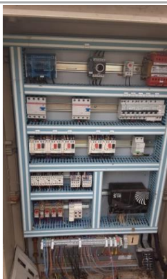
Armoire électrique (voyant défaut allumé pour la pompe de recirculation du clarificateur)
