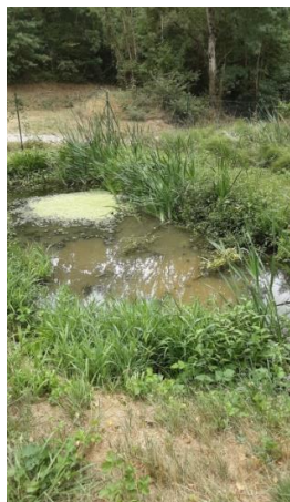
Zone de rejet végétalisée
