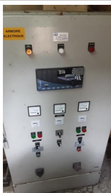
Armoire électrique - Soffrel S550
