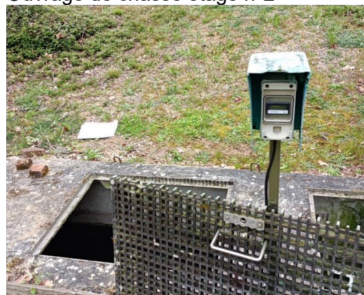
Ouvrage de chasse étage n°2
