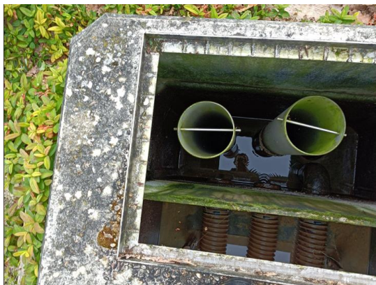
Ouvrage de répartition - 1er étage
