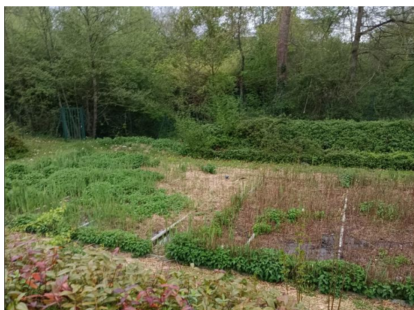
Filtre planté de roseaux - 2 lits - 2nd étage
