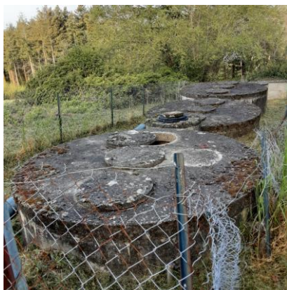
Vue générale de la station
