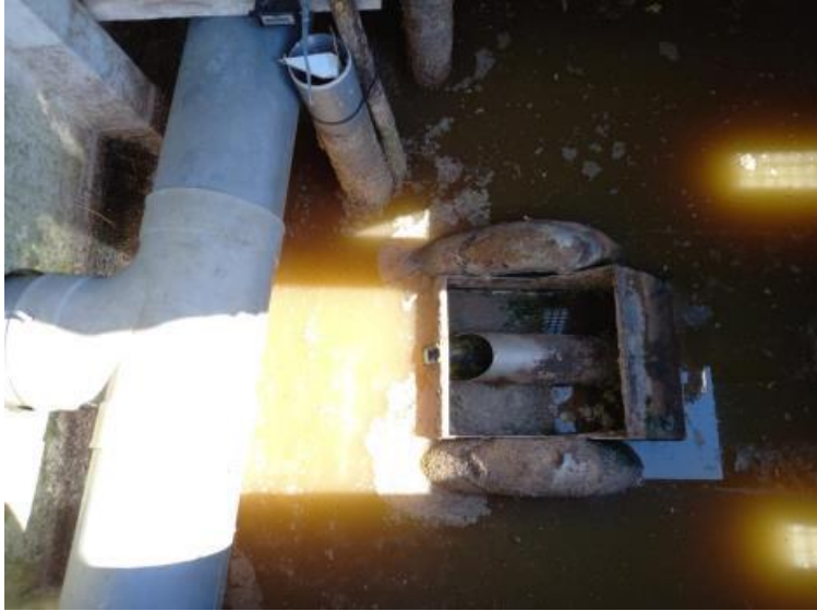
Ouvrage de répartition 1 er étage :
