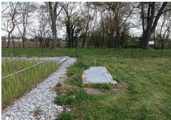
Canal venturi en sortie
