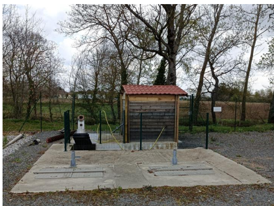
Vue générale local technique
