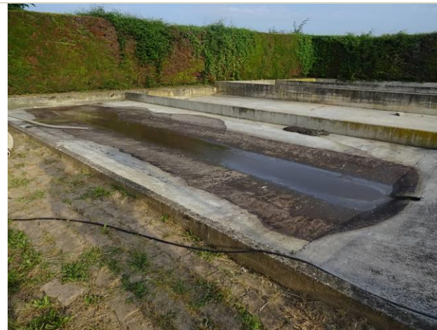
Vue d'ensemble de l'emplacement pour les géotubes
