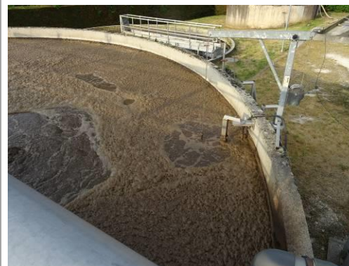
Potence (en haut) – Enceinte de dégazage – présence de filamenteuses (en bas à gauche) et évacuation par déversement (en bas à droite)
