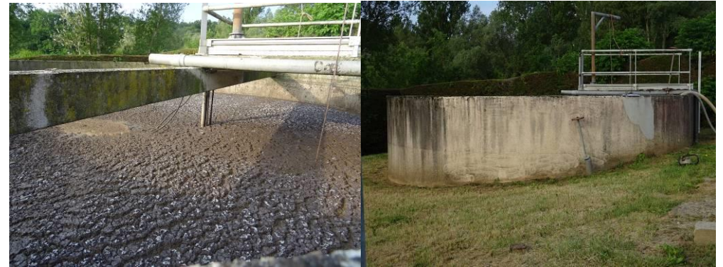
Vue d'ensemble du silo à boues
