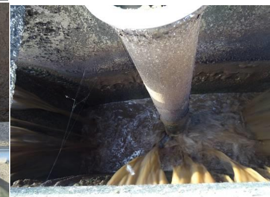
Potence (en haut) – Enceinte de dégazage – présence de filamenteuses (en bas à gauche) et évacuation par déversement (en bas à droite)
