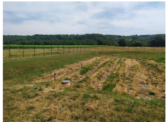
Filtre à sable
