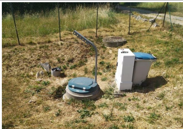
Poste de relevage
