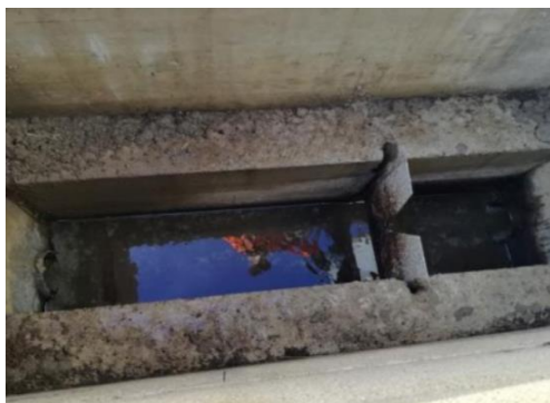
Canal de sortie
